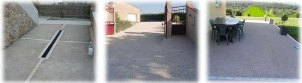
*Le béton désactivé procure un bel effet de matière grâce à la mise en relief de ses granulats.*
